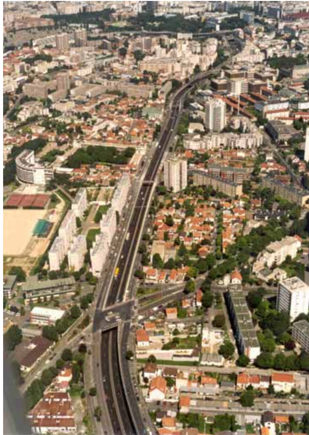
Vue aérienne de l'A6b
